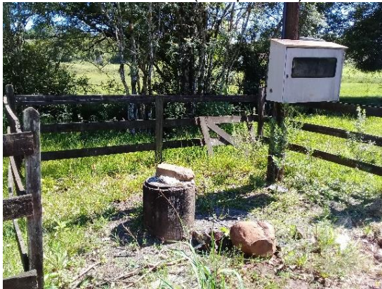
Figura 4.36 – Ponto de captação da localidade Linha Schuh (Tamponado)
