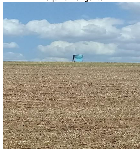
Figura 4.49 – Reservatório da localidade de Esquina Fungento
