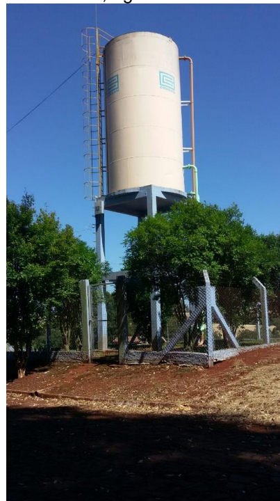
Figura 4.14 - Reservatório rua Pinheiro Machado, água tratada 50 m 3
