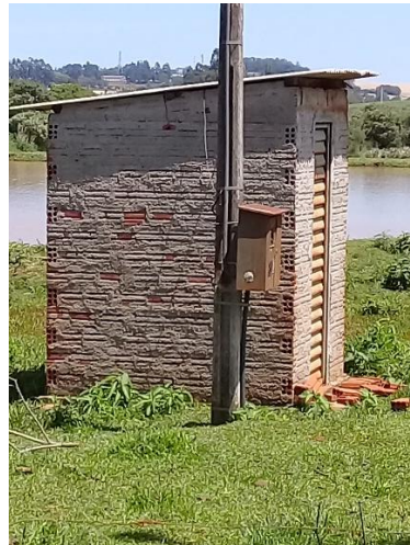
Figura 4.27 – Ponto de captação da Localidade de Herval Grande 2
