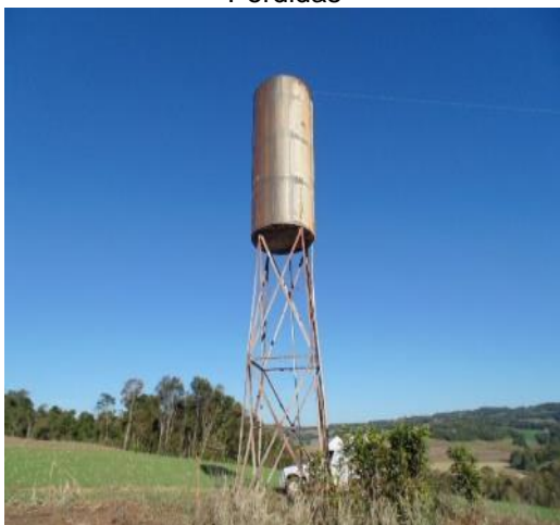
Figura 4.54 – Reservatório da localidade de Perdidas
