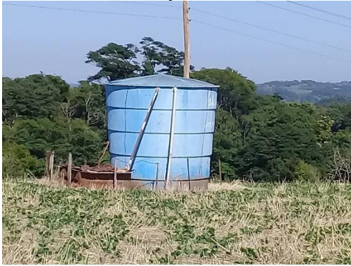
Figura 4.44 – Reservatório da Localidade de Lajeado Jacú
