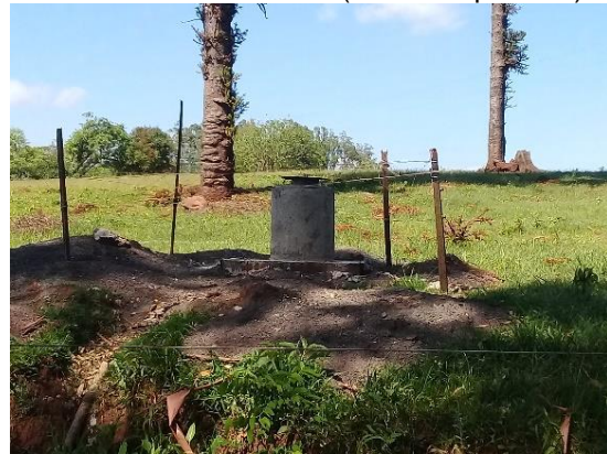
Figura 4.37 - Ponto de captação da localidade Linha Schuh (Ainda Inoperante)
