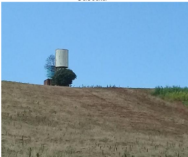
Figura 4.56 – Reservatório da localidade de Cascata
