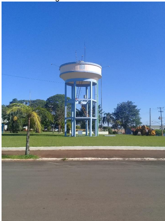
Figura 4.13 - Reservatório da Praça Getúlio Vargas, água tratada 50m 3
