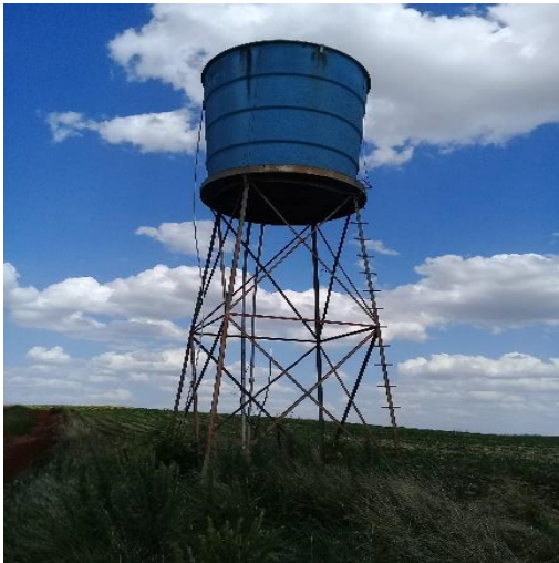
Figura 4.46 – Reservatório da localidade de Herval Grande
