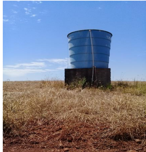
Figura 4.51 - Reservatório da localidade de Herval Grande 2
