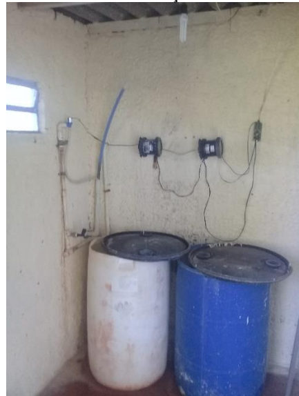
Figura 4.12 - Sistema de cloração e fluoretação
