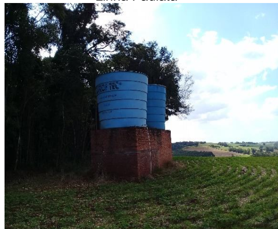
Figura 4.53 – Reservatório da localidade de Linha Paulata
