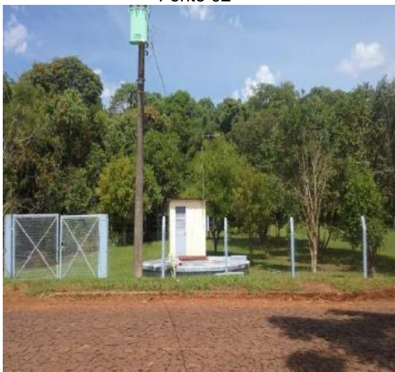
Figura 4.7 - Estruturas e casa de química Fonte 02
