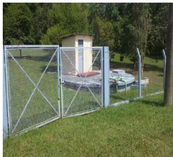
Figura 4.8 - Estruturas e casa de química Fonte 02
