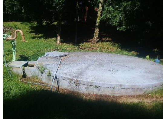
Figura 4.10 – Reservatório de Tratamento de Água
