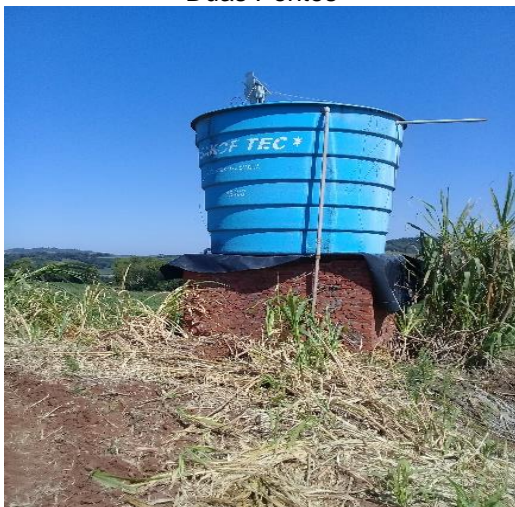
Figura 4.48 – Reservatório da Localidade de Duas Pontes
