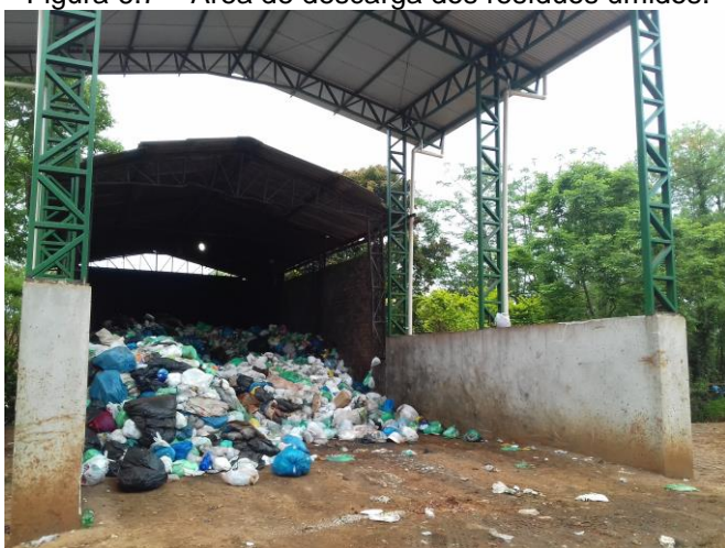
Figura 6.7 – Área de descarga dos resíduos úmidos.
