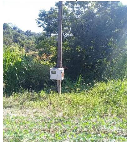
Figura 4.24 – Ponto de captação da localidade de Lajeado Jacu
