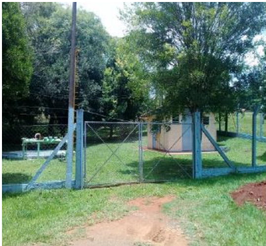
Figura 4.5 - Estruturas e casa de química Fonte 01
